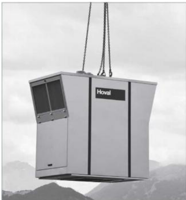
Мал. F6: Підйом дахової установки за допомогою прикручених кріплень для транспортування
